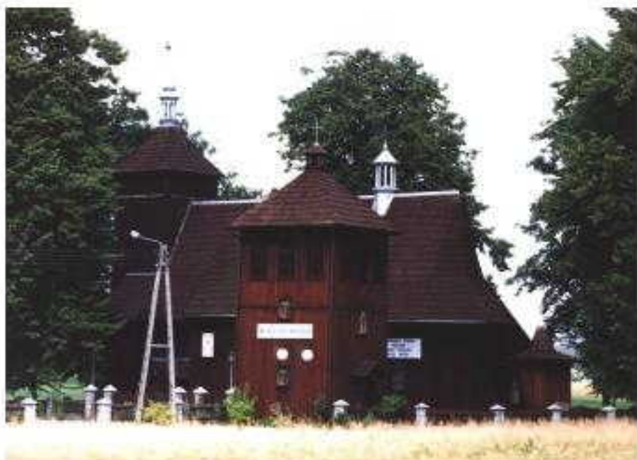
Tablica 6. Kościół pw. Trójcy Przenajświętszej w Jaworznie
