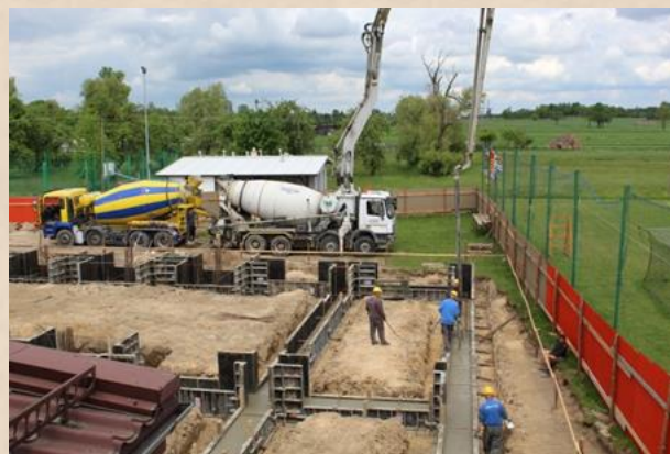
Początki prac budowlanych: wykopy oraz zalewanie fundamentów sali
