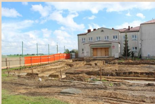
Początki prac budowlanych: wykopy oraz zalewanie fundamentów sali
